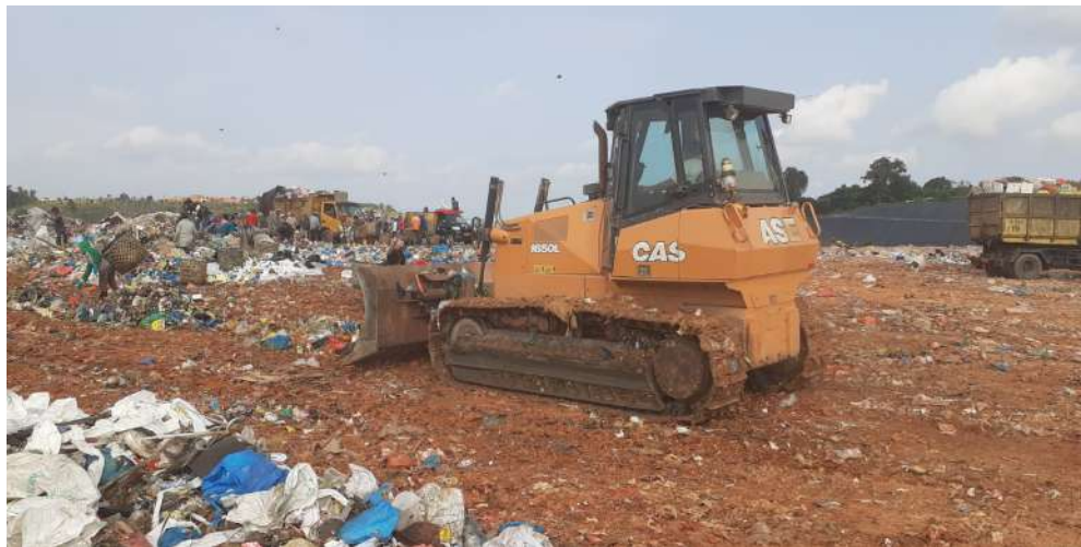
Gambar 29. Pengelolaan dengan Control Landfill di TPA Telaga Punggur
