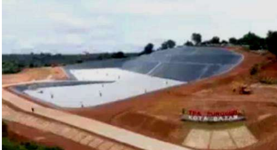
Gambar 3.4 Area TPA Telaga Punggur dengan Metode Sanitari Landfill
