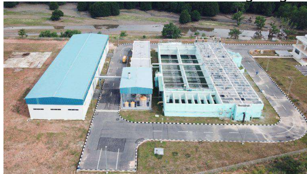
Gambar 10. Foto WWTP Bengkong
