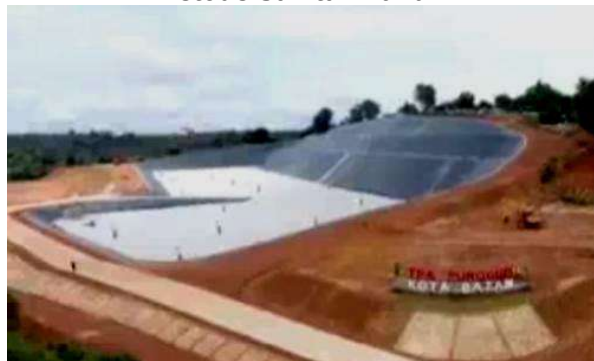
Gambar 5. Foto Area TPA Telaga Punggur dengan Metode Sanitari Landfill
