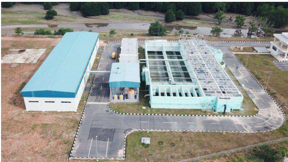
Gambar 4.1 Foto WWTP Bengkong
