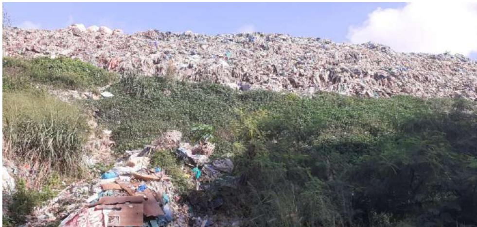
Gambar 2.22 Kondisi Sampah di TPA Telaga Punggur
