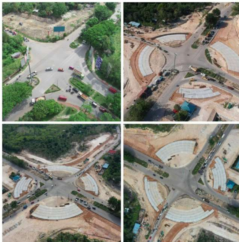
Gambar 4.19 Pelebaran yang dilakukan di Simpang Basecamp
