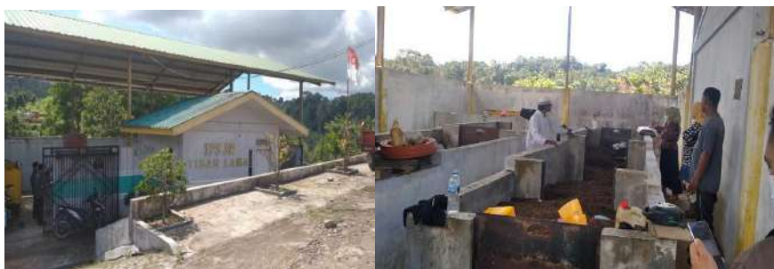
Gambar 23. Bangunan TPS 3R di Kec. Sekupang
