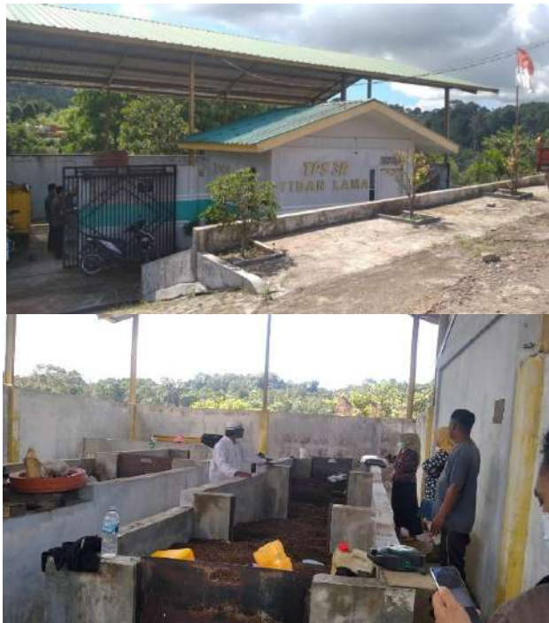
Gambar 4.27 Bangunan TPS 3R di Kec. Sekupang
