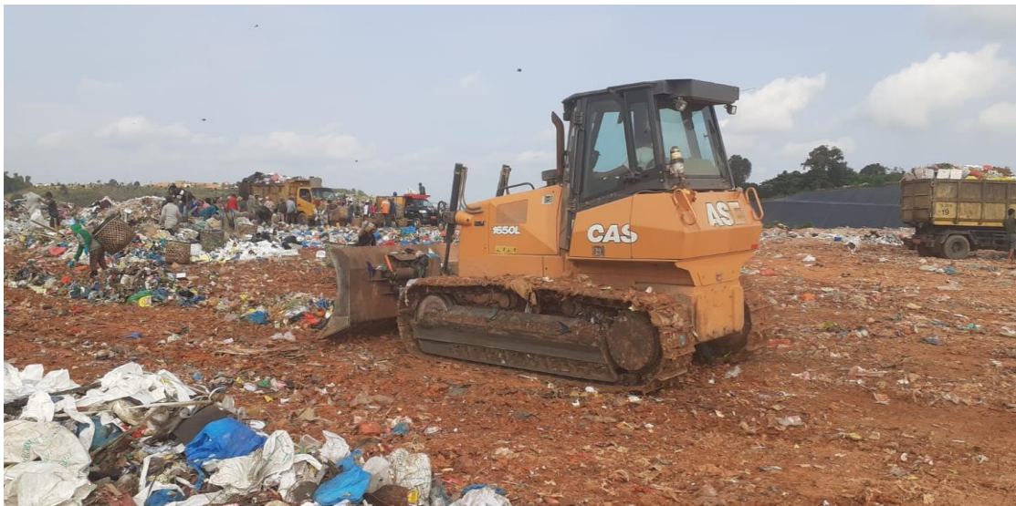
Gambar 2.23 Pengelolaan dengan Control Landfill di TPA Telaga Punggur
