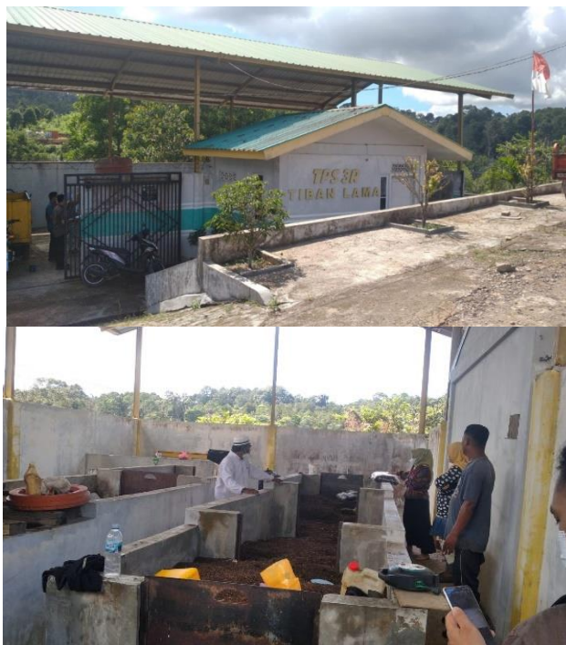
Gambar 4.27 Bangunan TPS 3R di Kec. Sekupang
