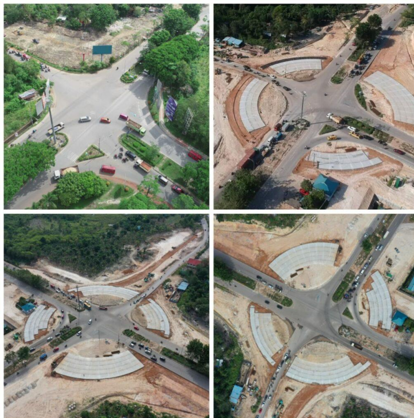
Gambar 4.19 Pelebaran yang dilakukan di Simpang Basecamp
