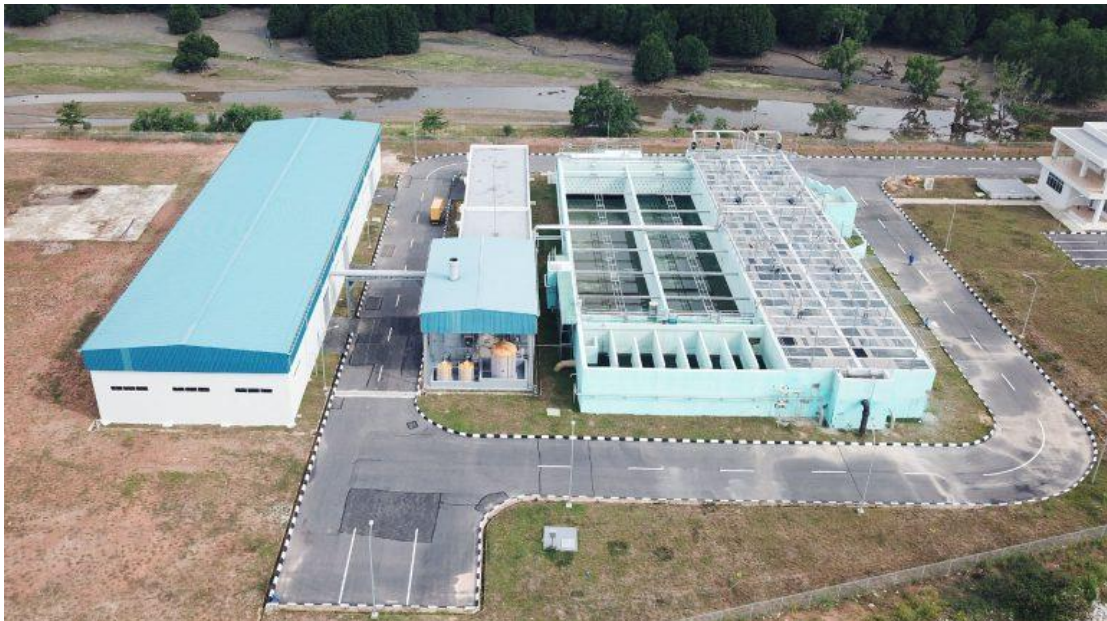
Gambar 4.1 Foto WWTP Bengkong
