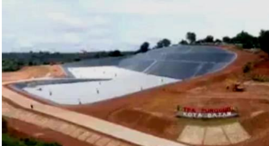
Gambar 3.8 Area TPA Telaga Punggur dengan Metode Sanitari Landfill
